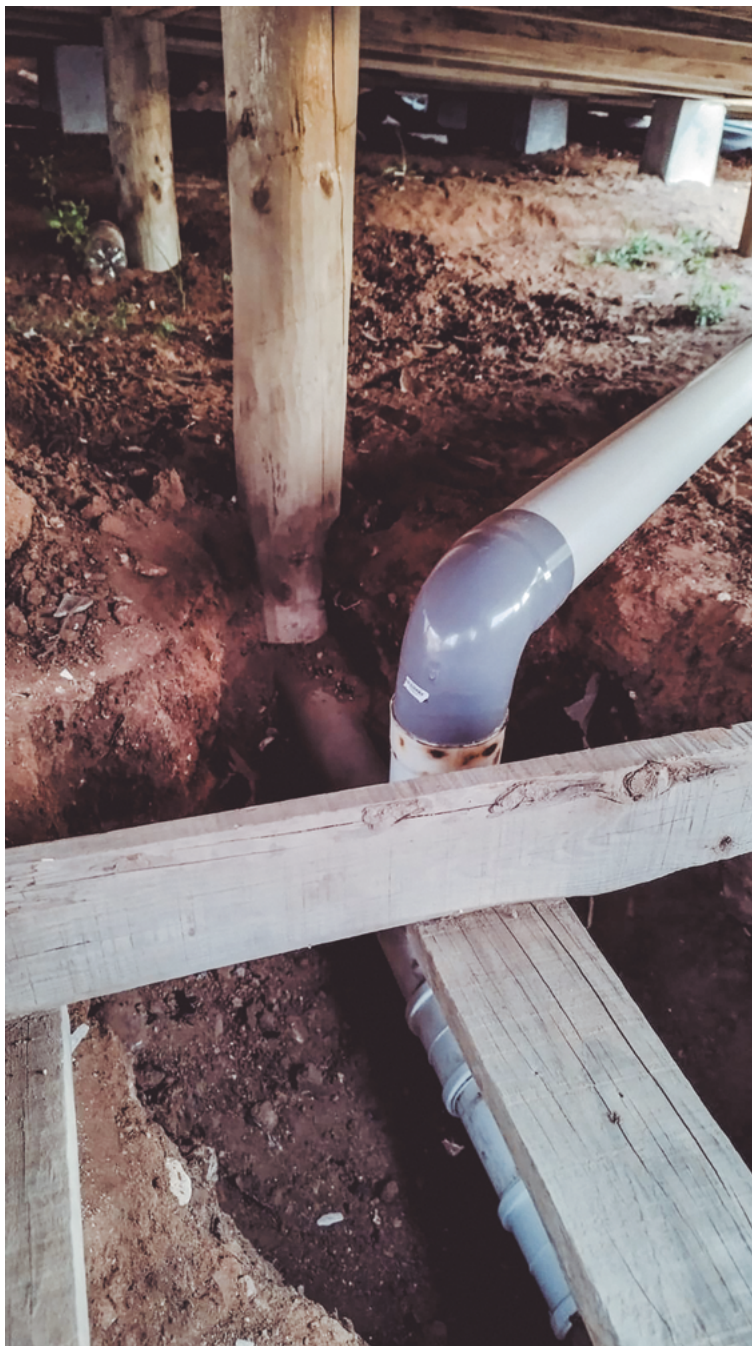
Fotografía tomada por el Área de Habitabilidad de Convocación. Durante la instalación de las viviendas de emergencia se pesquisaron diversos problemas, como se evidencia en la imagen, en donde los pilares fueron instalados encima de la red sanitaria provisoria.
